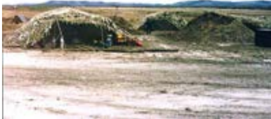
CARPAS DEL PERSONAL DE MANTENIMIENTO DAGGER EN LA CABECERA 25
