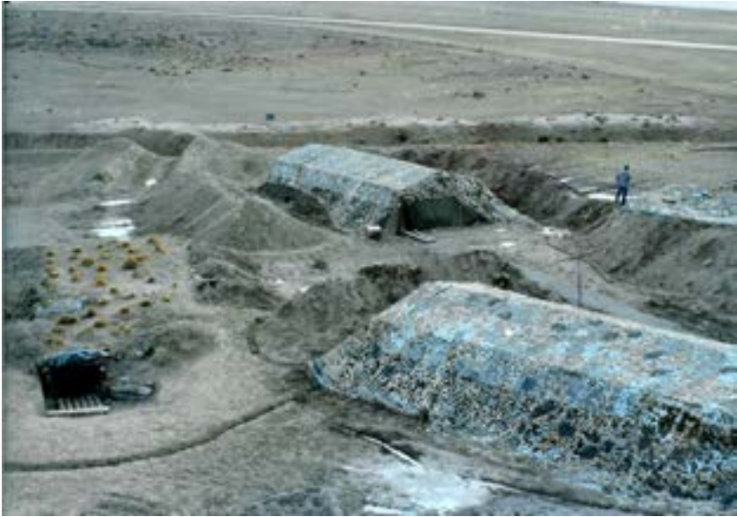
ENTRADA AL REFUGIO ANTIAÉREO Y CARPAS UTILIZADAS PARA RESGUARDO DEL MATERIAL Y PERSONAL DE LA CABECERA 25
