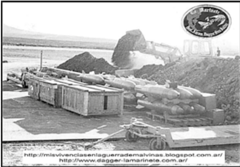
EN LA CABECERA 07, ACOPIO DE BOMBAS Y MÁQUINA ESCABADORA CONSTRUYENDO MAMELÓN PROTECTOR
