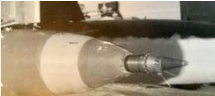
ESPOLETA SÚPER RÁPIDA SSQ (SUPER, SUPER QUICK ) QUE PERMITE HACER EXPLOTAR LA BOMBA A 1 M DEL SUELO
