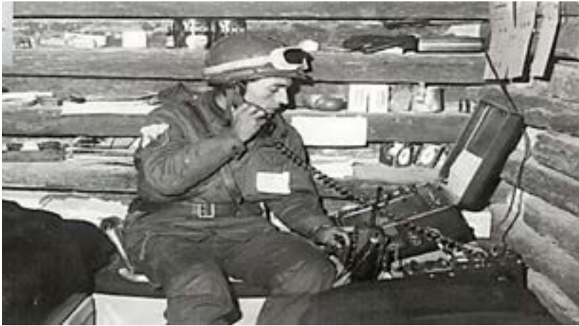
PERSONAL DE COMUNICACIONES. OBSÉRVESE QUE LAS INSTALACIONES SON SUBTERRÁNEAS.
