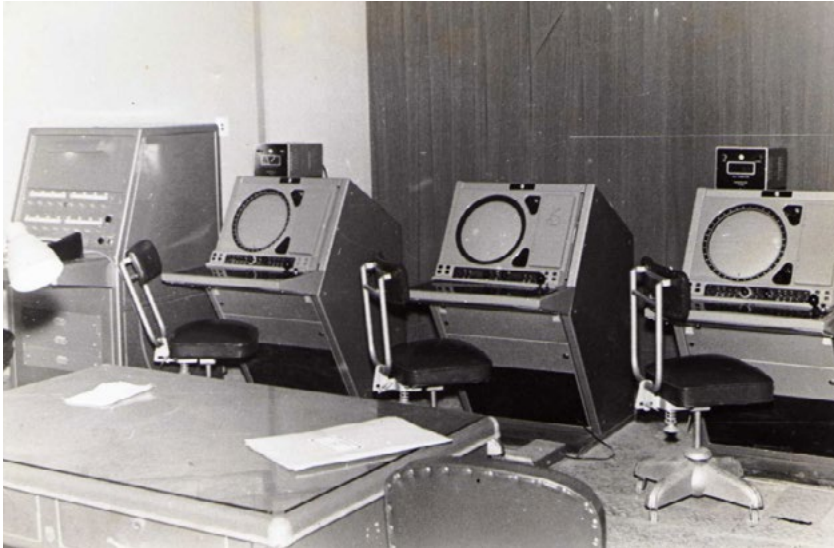
Consolas del Sistema Marconi en el CIC Merlo. Autor: desconocido, archivo fotográfico AEVYCA
