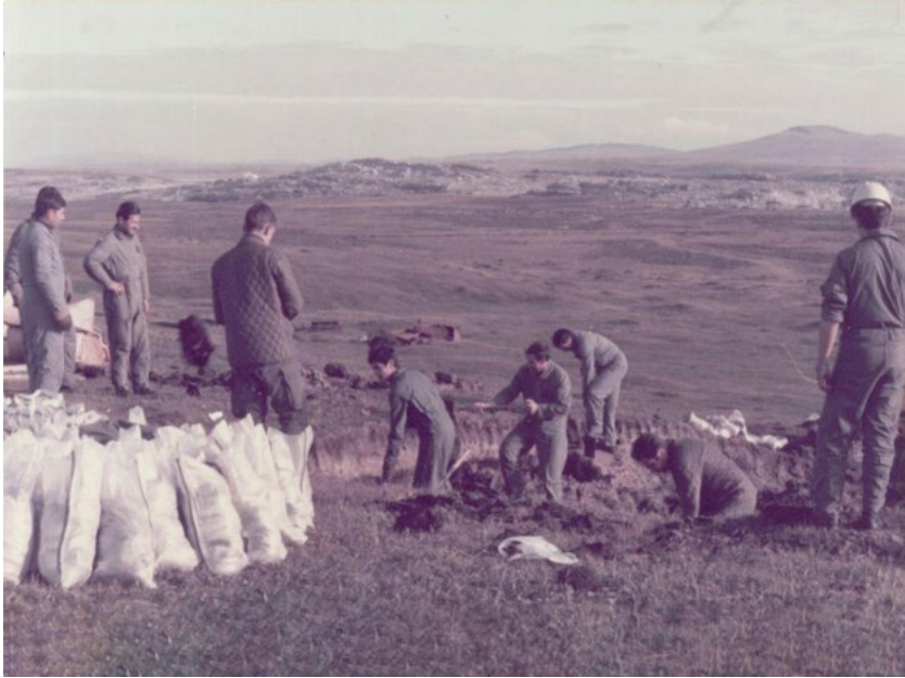
Preparación del predio del radar en zona del aeródromo Malvinas
